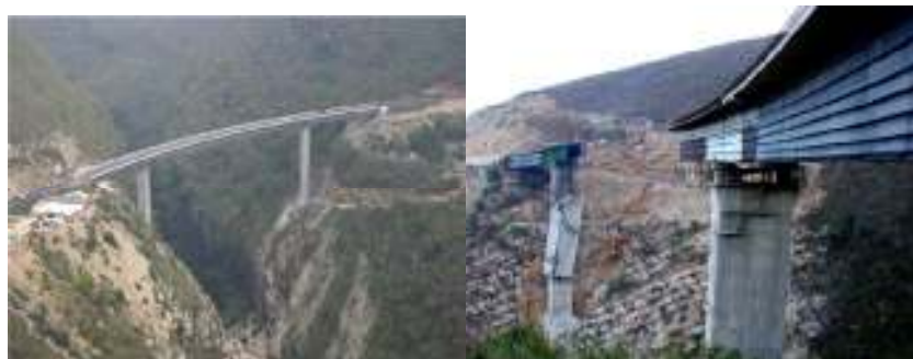
Figura 2: Colapso del puente San Cristóbal.
